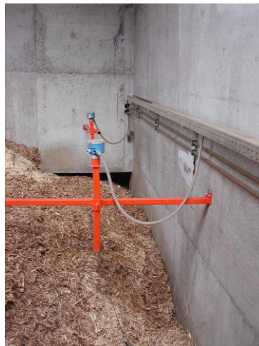
Figura 2 Canale di carico
